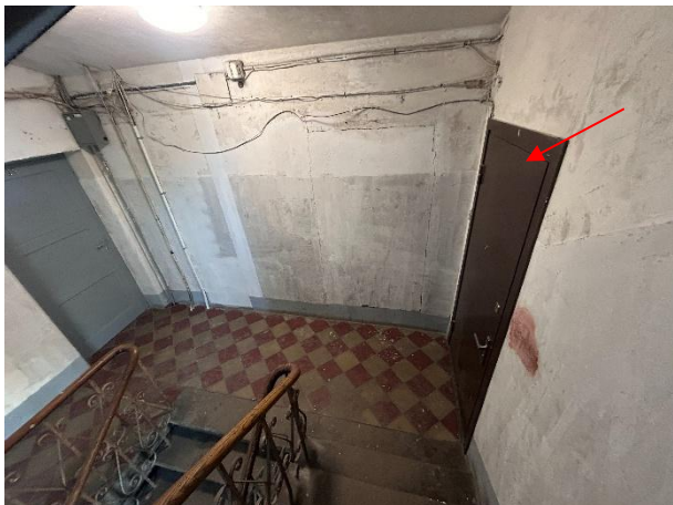
Skats uz kāpņu telpu un dzīvokļa durvīm.
