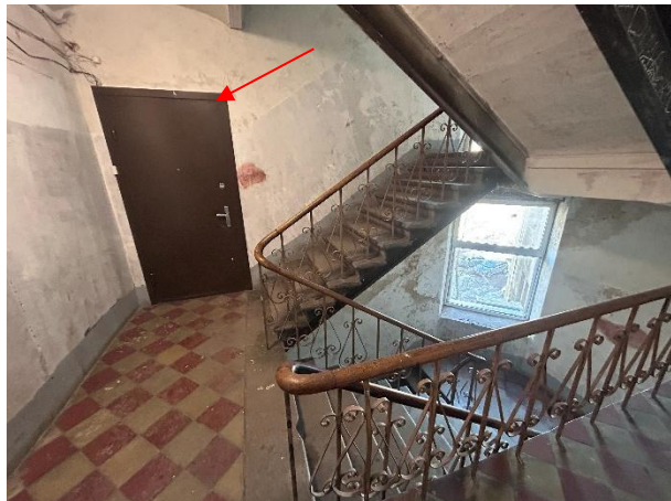
Skats uz kāpņu telpu un dzīvokļa durvīm.
